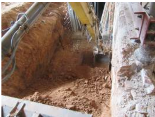
Foto 73. Excavació Pou 11. Vista des del nord-est.
