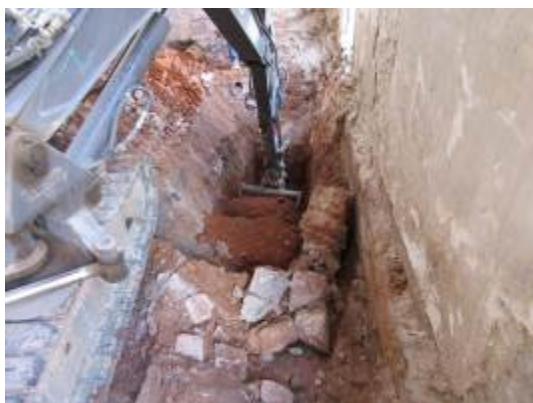
Foto 5. Excavació Rasa 2. Vista des del nord-est.
