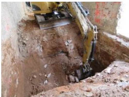
Foto 11. Excavació Rasa 4. Vista des del nord-est.
