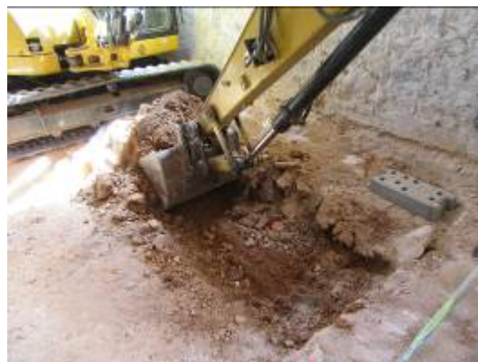
Foto 22. Excavació Rasa 8. Vista des del nord.
