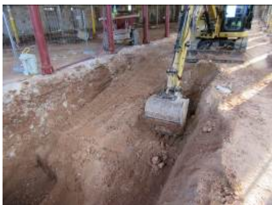
Foto 59. Excavació Galeria 1 Tram 4. Vista des del nord-est.
