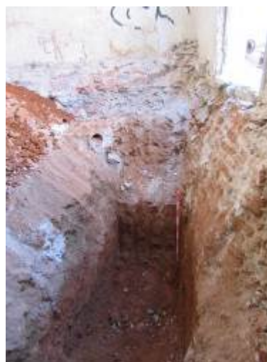
Foto 6. Final Rasa 2. Vista des del nord-est.
