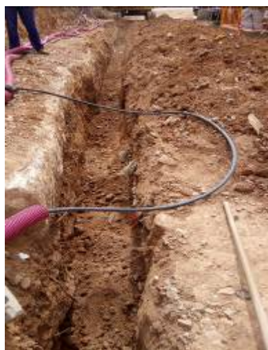
Foto 29. Final Rasa 10. Vista des del nord-est.
