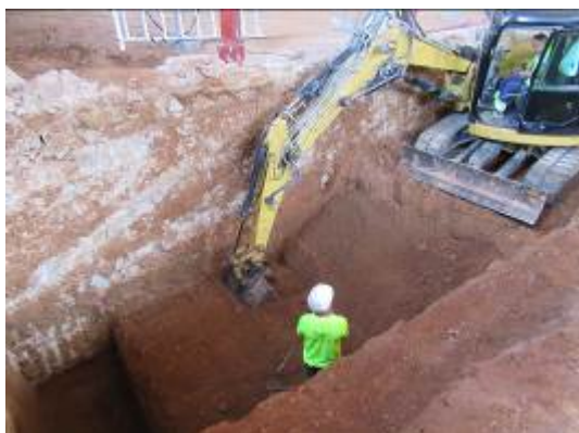
Foto 35. Excavació Pou 2. Vista des del sud.
