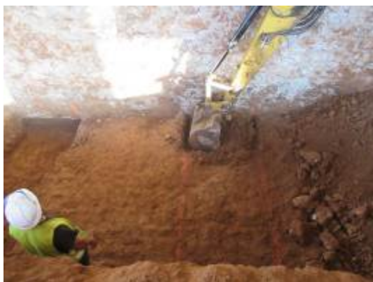
Foto 57 .Excavació Pou 8 . Vista des del sud-est.
