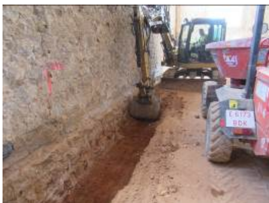
Foto 19. Excavació Rasa 7. Vista des del nord-est.
