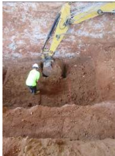
Foto 38. Excavació Pou 3. Vista des del sud-est.
