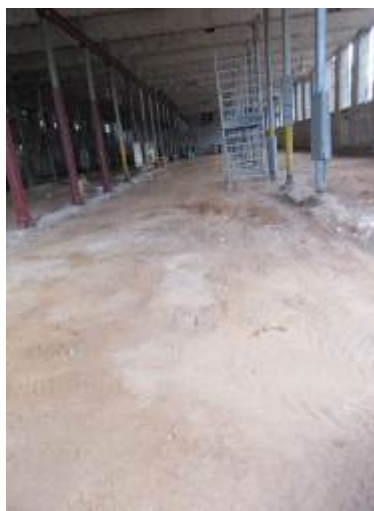
Foto 30. Inicial Galeria 1 Tram 1. Vista des del sud-oest.
