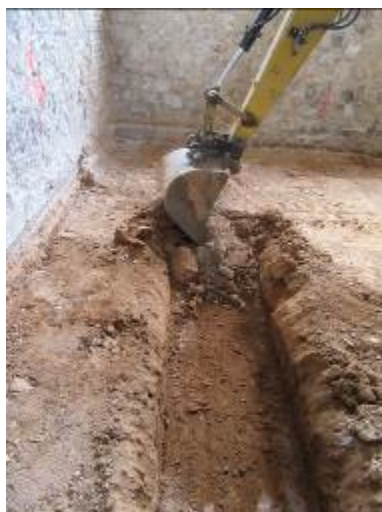
Foto 17. Excavació Rasa 6. Vista des del nord-oest.
