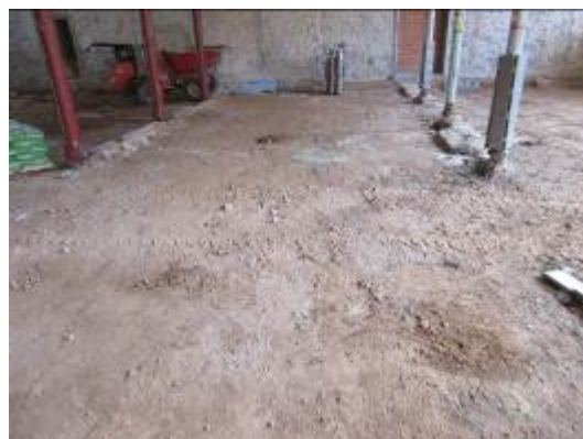
Foto 42. Inicial Galeria 1 Tram 2. Vista des del sud-oest.
