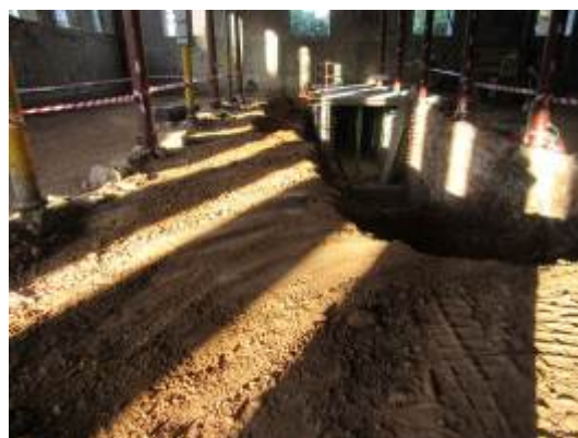
Foto 60. Final Galeria 1 Tram 4. Vista des del sud-oest .
