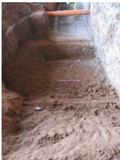
Foto 69 .Final Galeria 1 Tram 5 . Vista des del nord-est.
