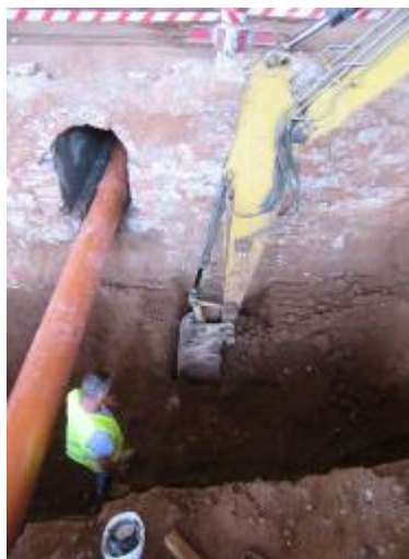
Foto 78. Excavació Pou 13, a prop d'una canalització existent i encara en ús. Vista des del sud-est.
