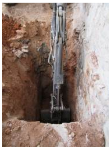
Foto 8. Excavació Rasa 3. Vista des del sud-oest.
