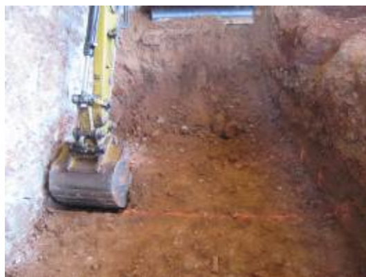
Foto 88 . Excavació Pou 17. Vista des del sud-oest.
