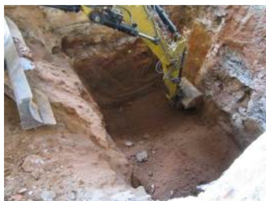
Foto 14. Excavació Rasa 5. Vista des del sud-oest.
