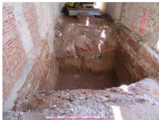
Foto 12. Final Rasa 4. Vista des del nord-est.
