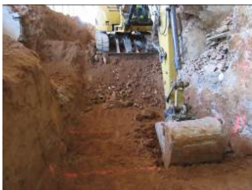
Foto 47. Excavació Pou 5. Vista des del nord-est.
