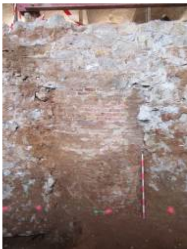
Foto 71. Riostra de l'edifici actual adossada al pou UE 5. Vista des del sud-est.
