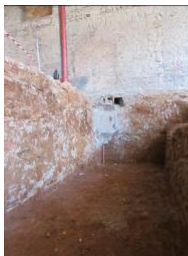
Foto 44. Final Galeria 1 Tram 2. Vista des del sud-oest.
