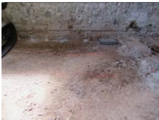
Foto 21. Inicial Rasa 8. Vista des del nord-est.
