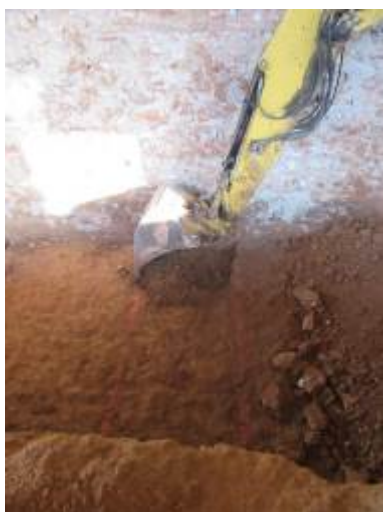
Foto 65 .Excavació Pou 10 . Vista des del nord-est.
