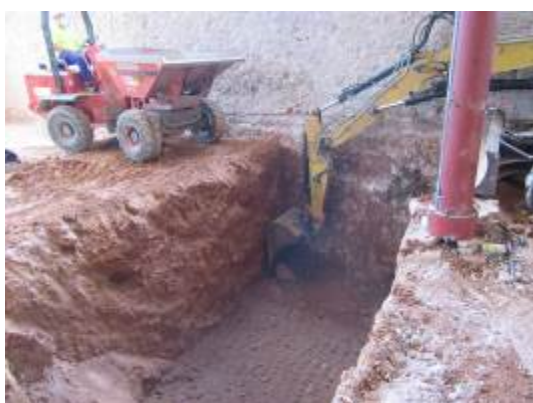
Foto 31. Excavació Galeria 1 tram 1. Vista des del nord-est.
