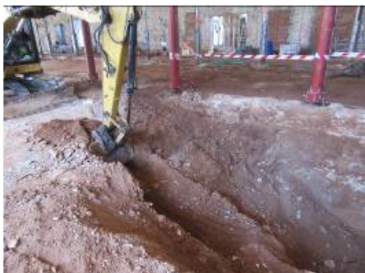
Foto 43. Excavació Galeria 1 Tram 2, vist des del sud-est.
