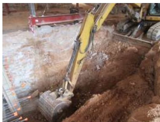
Foto 68. Excavació Galeria 1 Tram 5.
