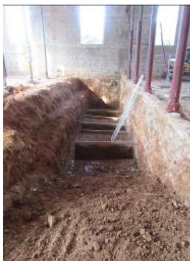
Foto 32. Final Galeria 1 Tram 1. Vista des del nord-est.
