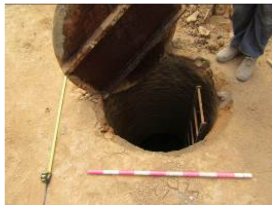
Foto 92. UE 7. Vista des del nord-oest.
