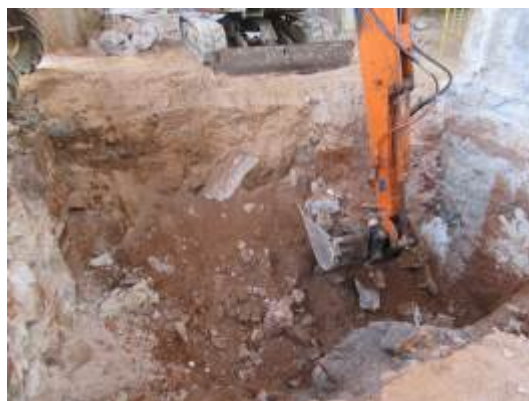
Foto 24. Excavació Rasa 9. Vista des del nord-oest.
